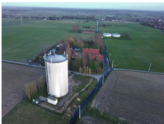
RESERVOIRS ET CHATEAU D'EAU – MORBECQUE
