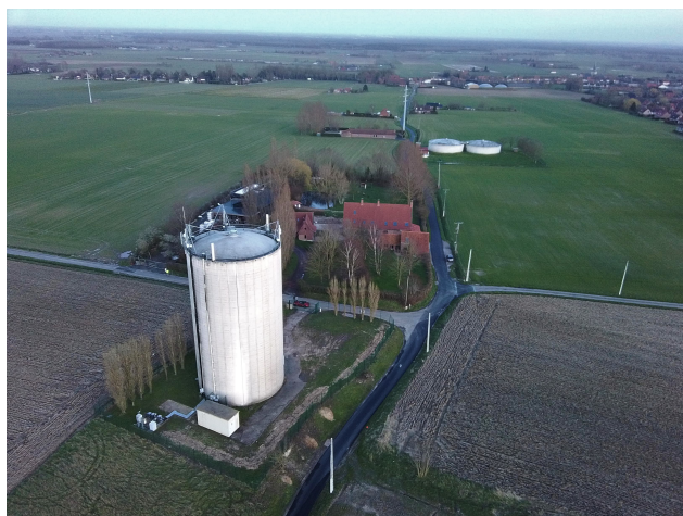
RESERVOIRS ET CHATEAU D'EAU – MORBECQUE
